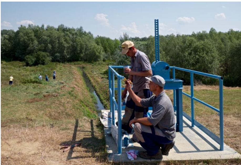
Zsilip acélszerkezetének festése
