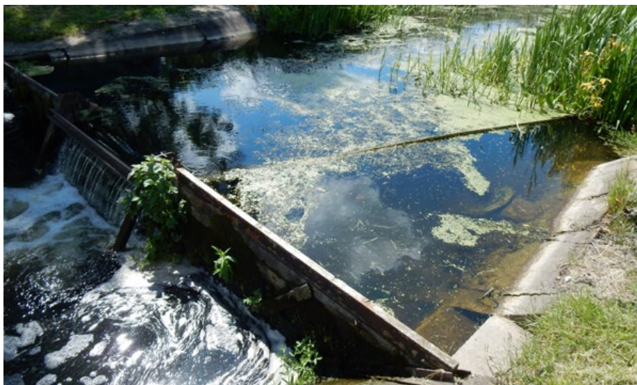
Duzzasztó műtárgy a Kállai-főfolyás 6+120 km szelvényében
