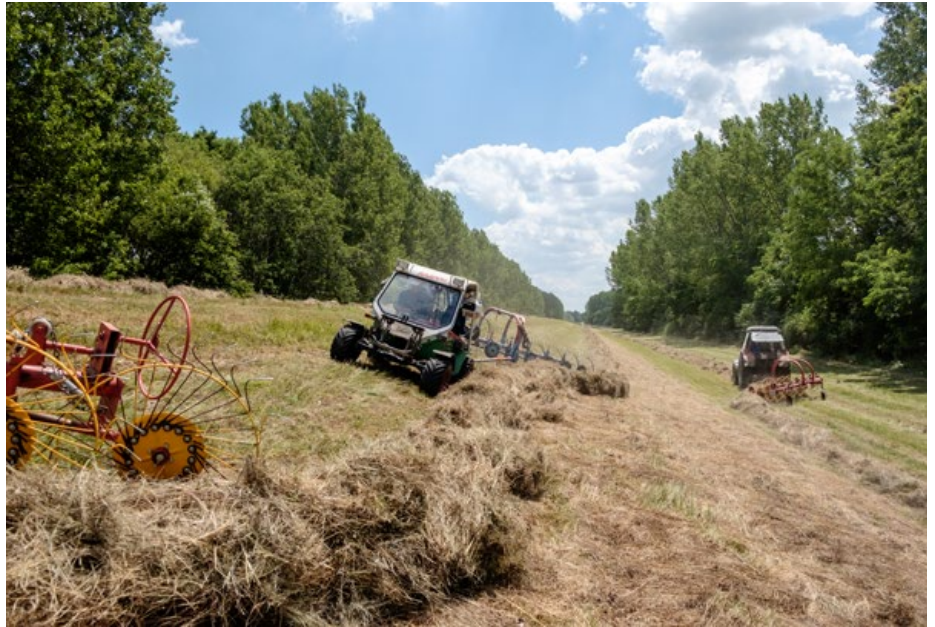
Árvízvédelmi töltés gyepfelületének karbantartása (lekaszált széna rendsodrása)
