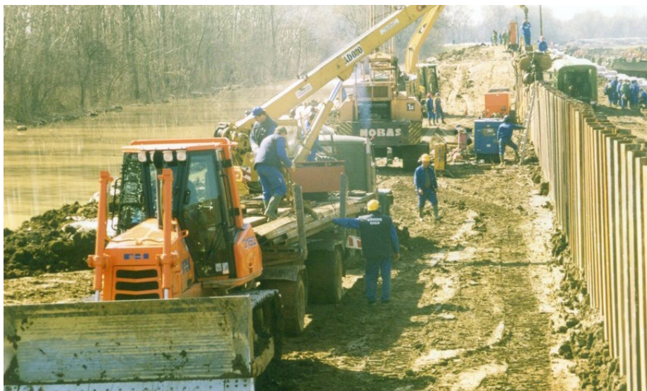
Szádfalazási munkálatok az átszakadt Tisza jobb parti töltésén
