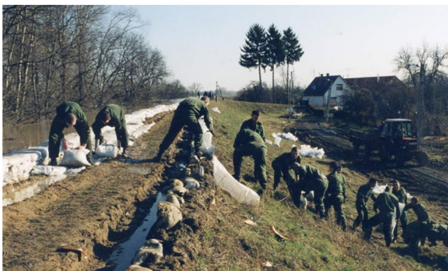
Nyúlgátépítés Kisar település védelmére
