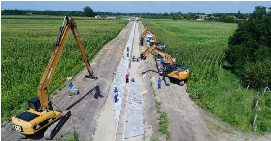
Padkaépítés a medertározós szakaszon
