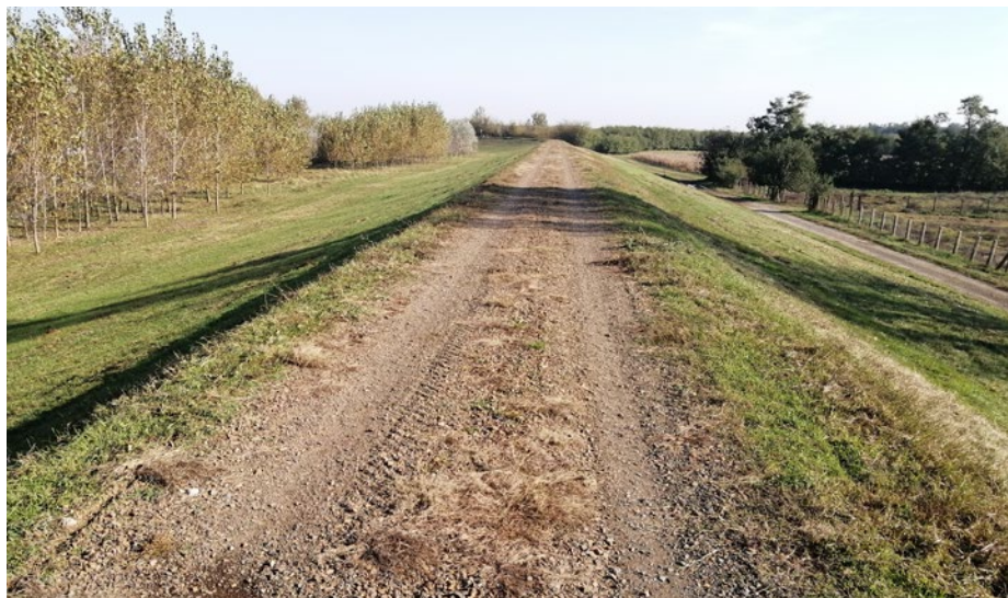
Stabilizált töltés Dombrád térségében
