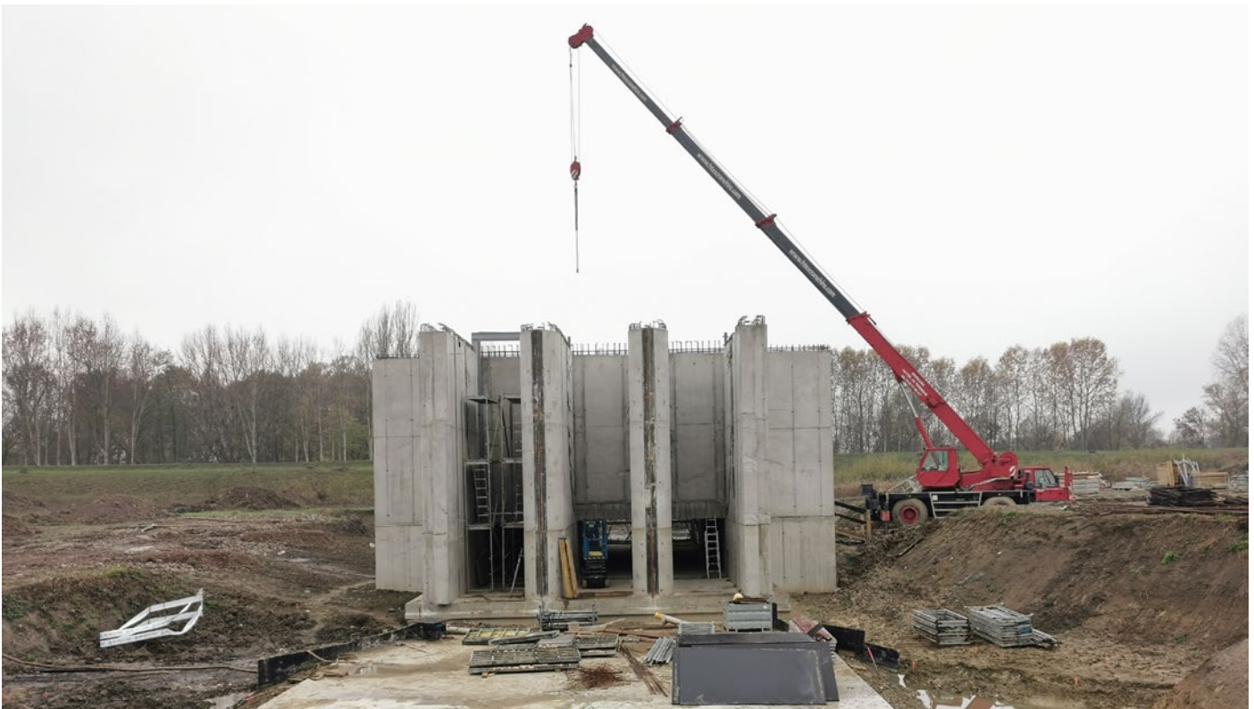
Épül a leürítő műtárgy a Tisza-Túr tározónál
