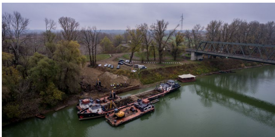
Uszadékok eltávolítása a II. Rákóczi Ferenc közúti Tisza-hídnál
