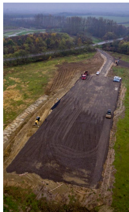
Hulladékválogató telep építése Vásárosnamény térségében
