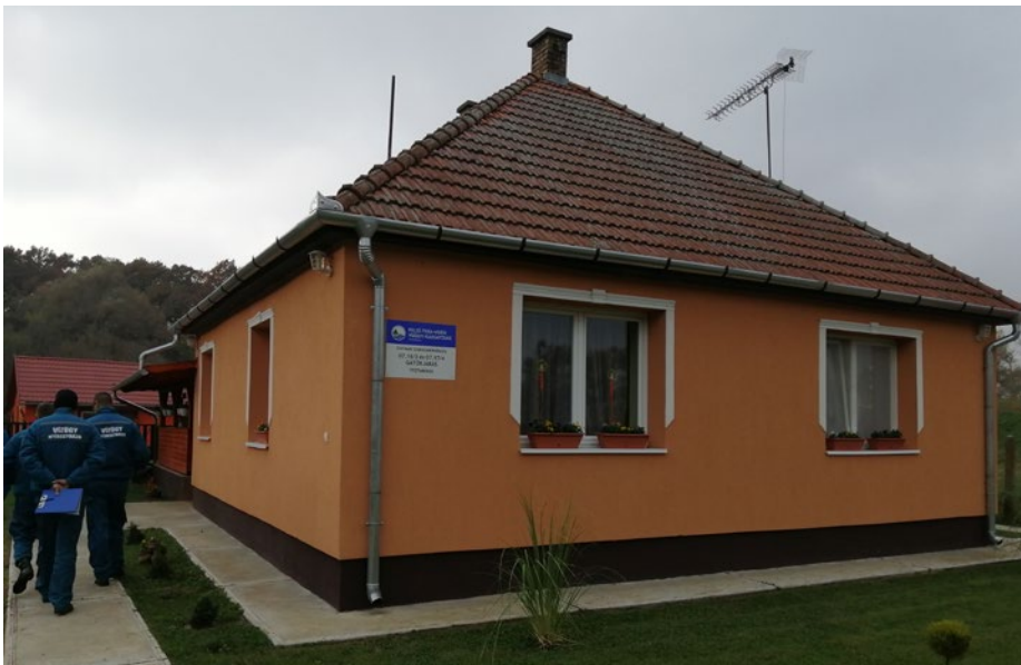
Tisztaberki felújított gátórház
