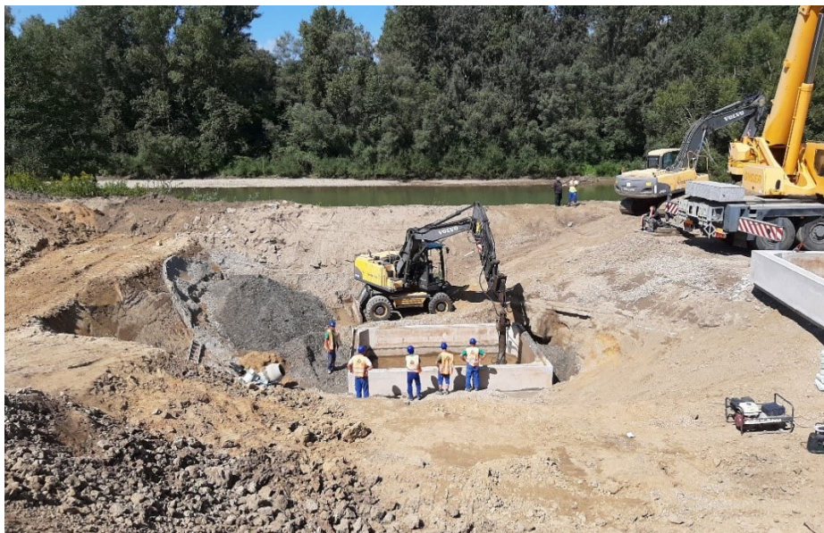
Tiszai szivattyúakna keretelemeinek süllyesztése Tiszabecsnél
