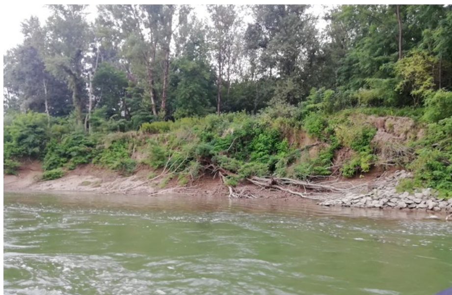
Mederfelújítás Tiszabecs-Milota között
