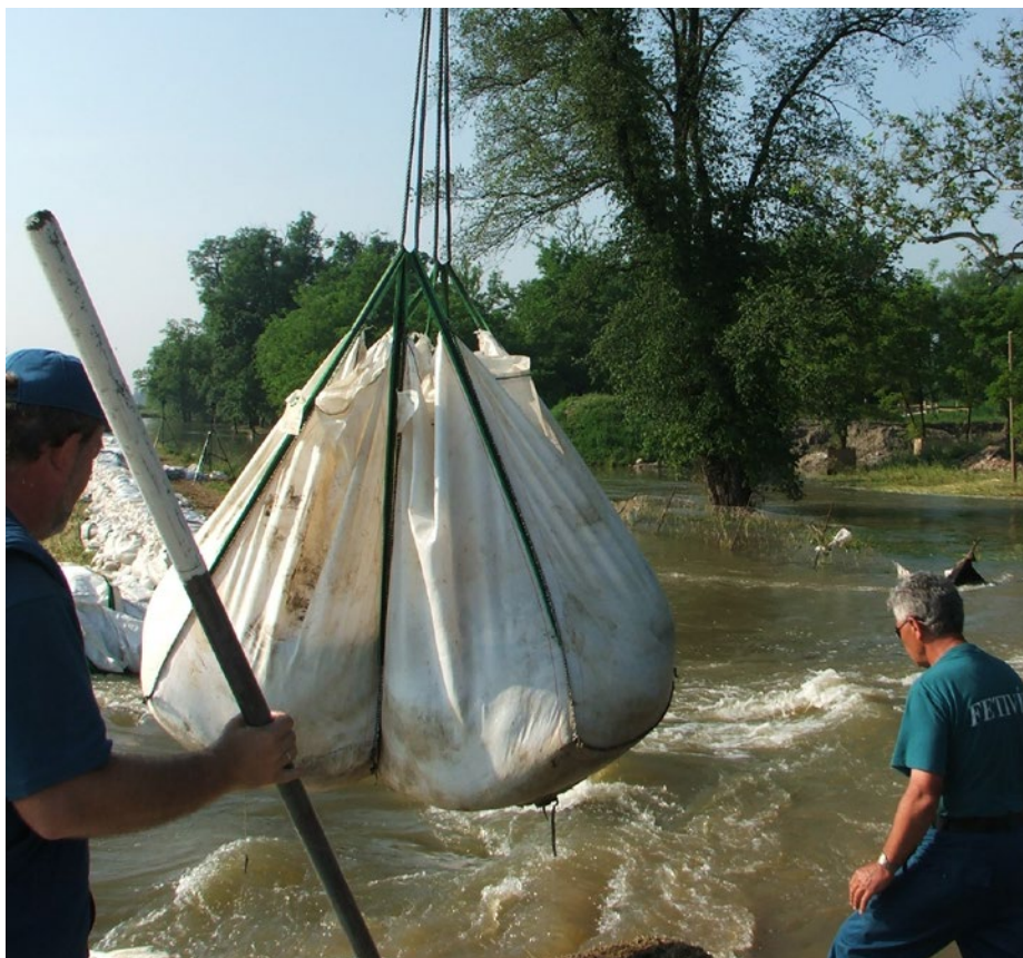
A víz kitörésének útját big-bag zsákokkal zártuk el
