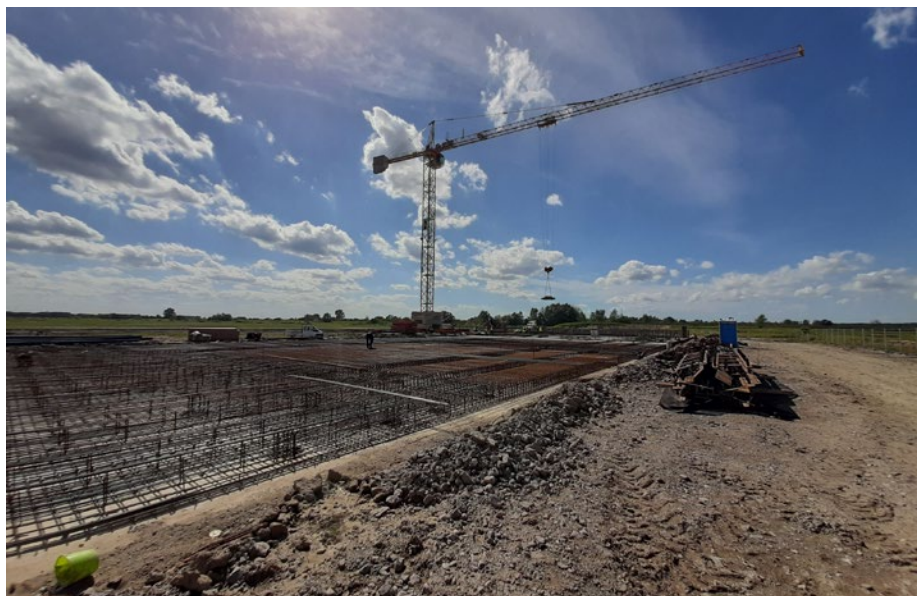
Beeresztő műtárgy alaplemez II. ütemének vasszerelése
