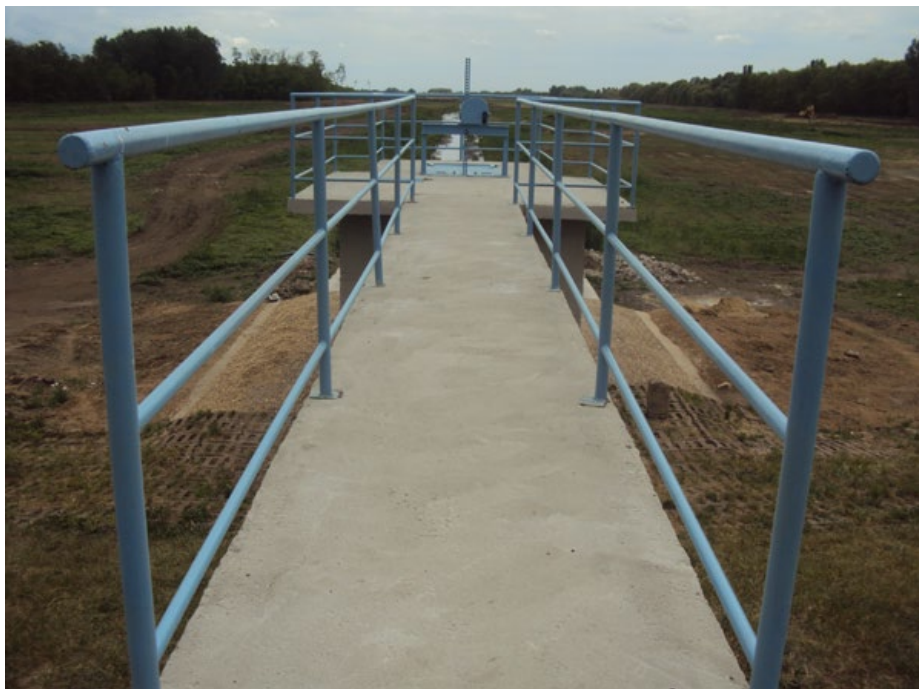
A felújítás alatt álló leeresztő műtárgy
