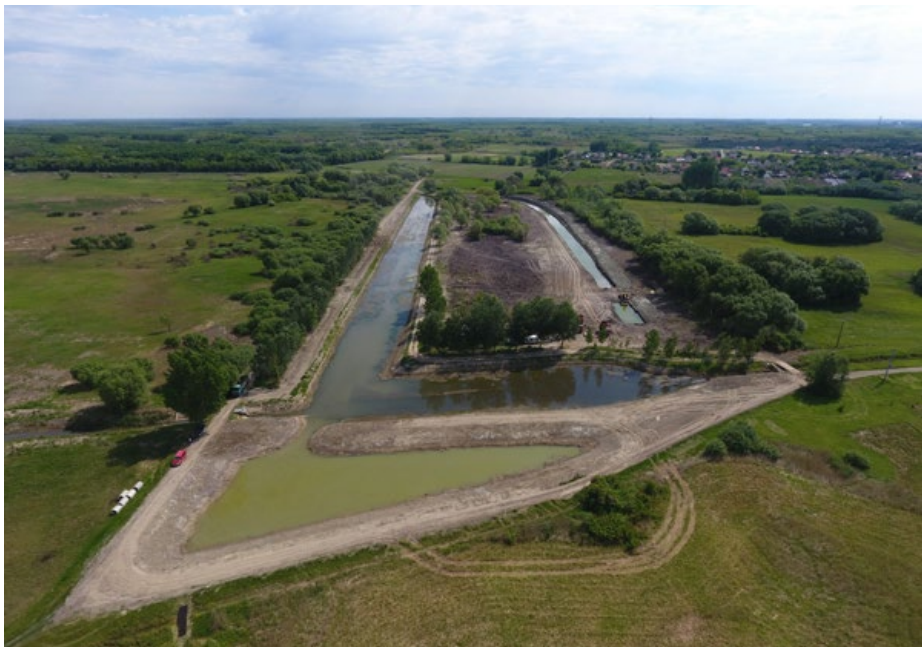
A megkotort előülepítő mellett épülő új előülepítő
