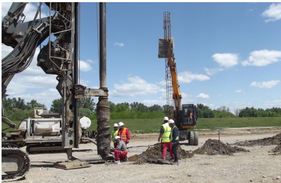
Cölöpök fúrása speciális kiképzésű fúrófejrel
