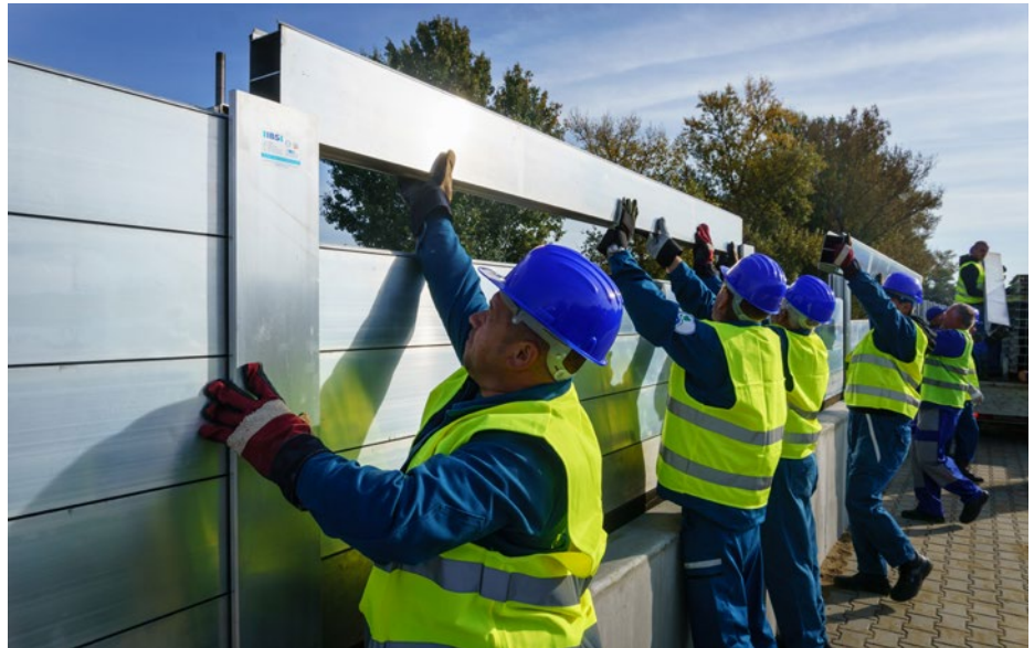
Árvízvédelmi mobilfal összeszerelése Kisar településen
