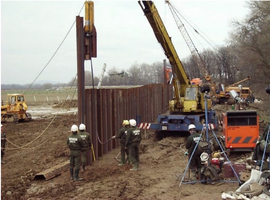
5. fénykép Acéllemez szádfal sor verése, a Tisza jobb partján
