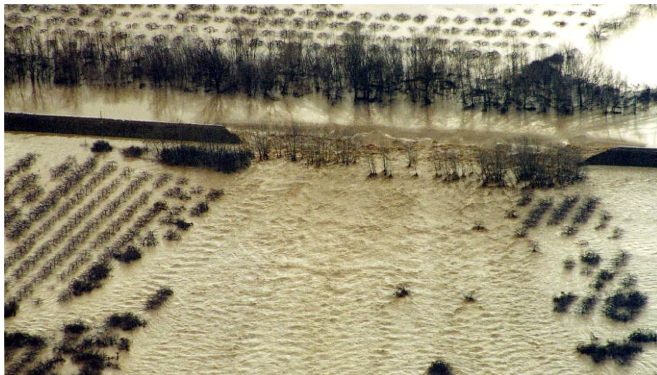
3. fénykép Tarpai gátszakadás 2001.03.06-án a levegőből
