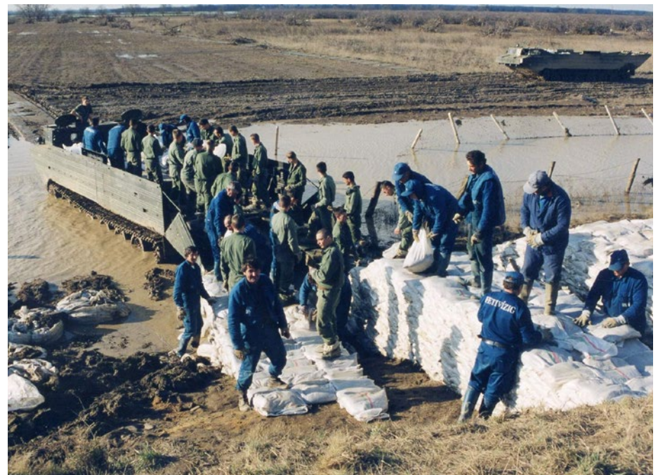
6. fénykép Bordás megtámasztás építése Tarpa térségében
