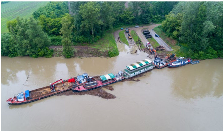
Részleges mederelzárás Vásárosnaményban
