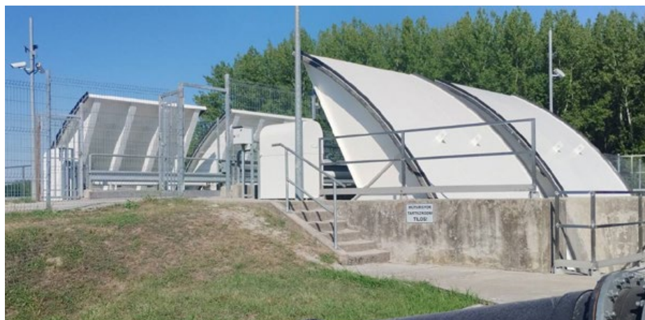
A Lónyay árvízkapu szegmenstábláinak rekonstrukciója megtörtént
