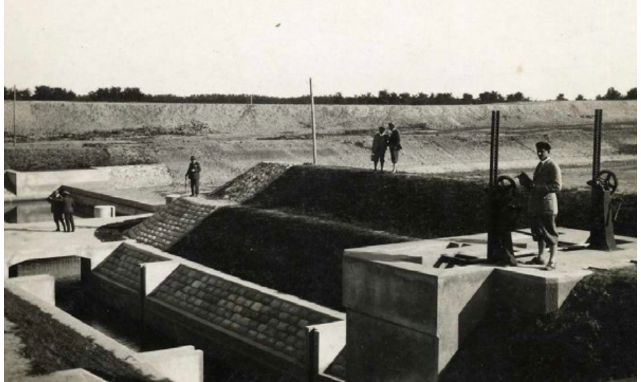
A sonkádi vízostómű építése közben
