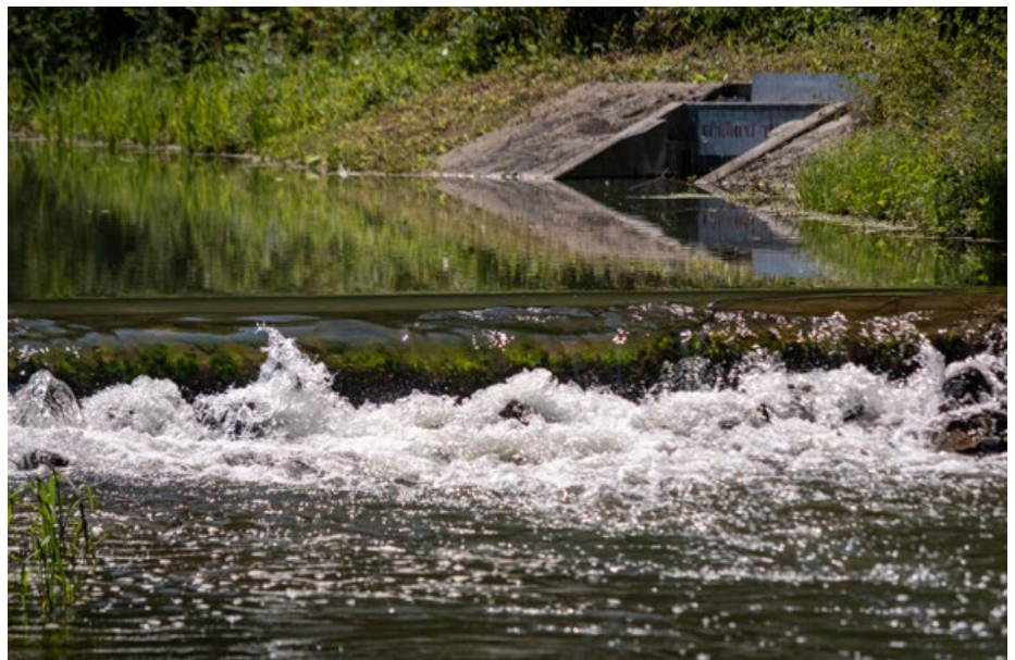
A Vízpótló-csatorna 4+400 km szelvényénél épített ideiglenes mederelzáráson átbukó víz, háttérben a V2 jelű zsilippel
