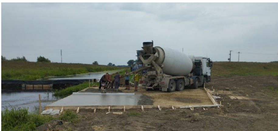
Felvonulási terület és szivattyúállás kialakítása (Kótaj)
