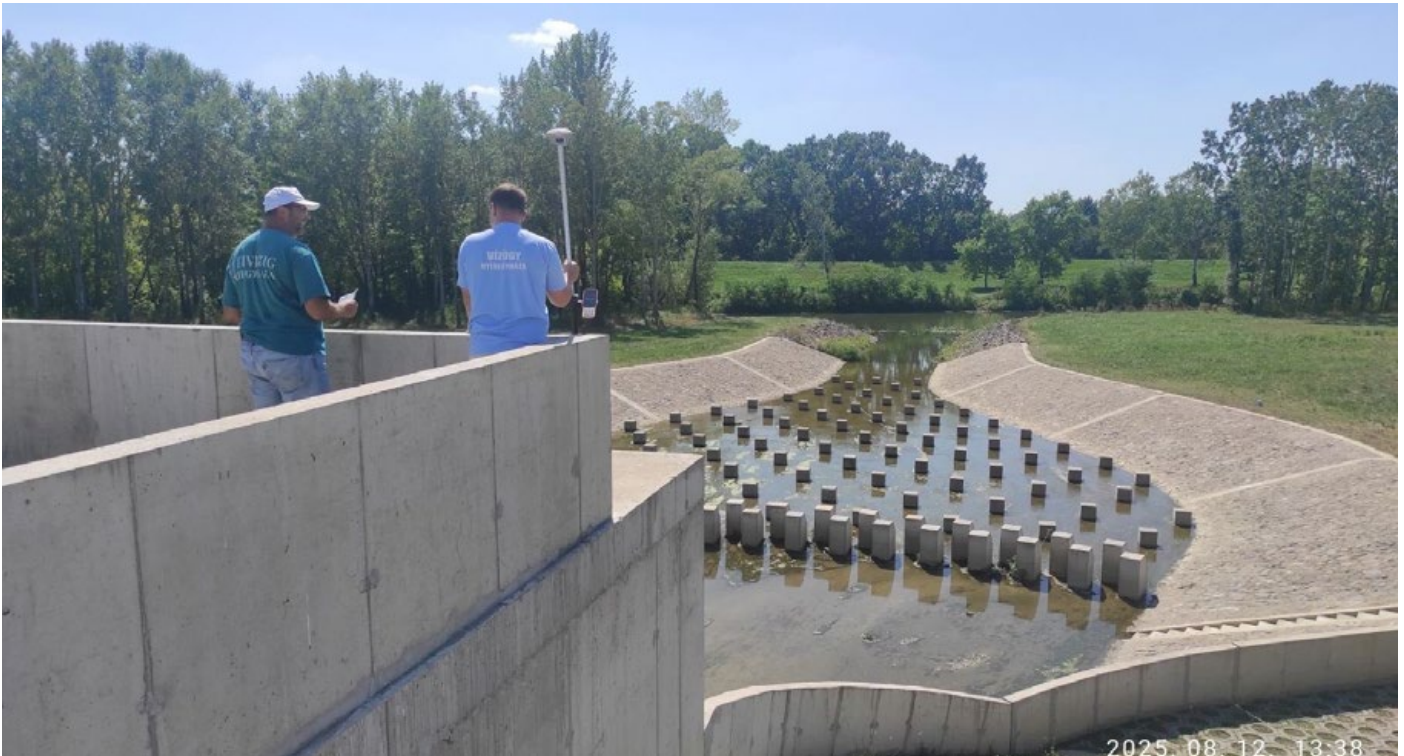
A leeresztő műtárgy és a Túr folyó csatlakozása Tiszakóród közelében
