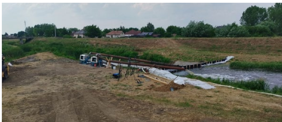
Szivattyúzás Kótaj térségében
