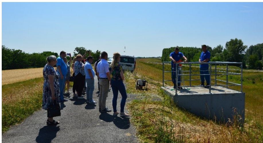
Palád-Csécsei főcsatorna torkolati zsilip AUMA hajtóművel mozgatott felhúzó szerkezetének üzempróbája
