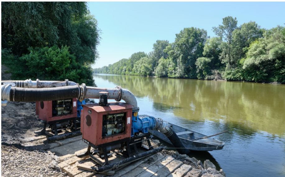
Szivattyúzás Szamossályi térségében
