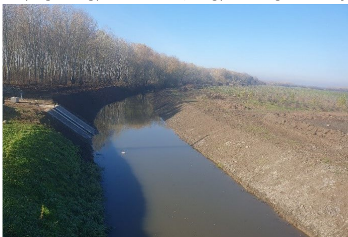
A Kraszna-ágerdőmajori vízmérce szelvénye a fejlesztést és mederrendezést követően
