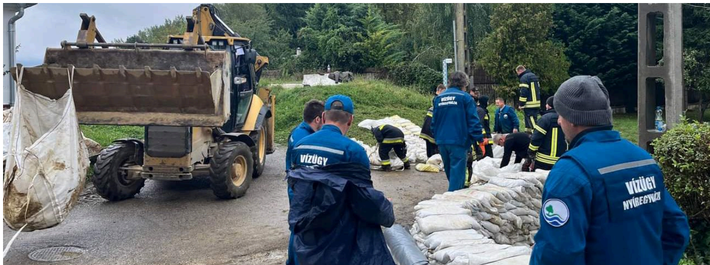
Nyúlgát építését végzik kollégáink
