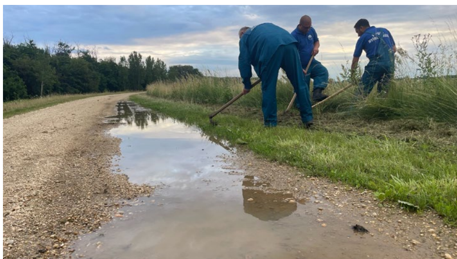
Töltéskorona víztelenítési munkái a Rába mentén
