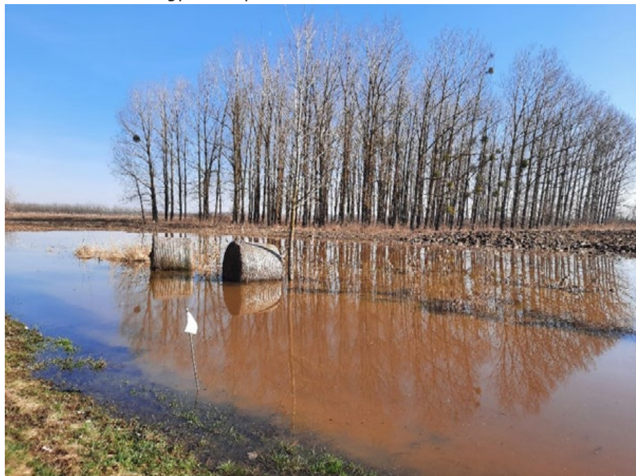
Észlelt talpszivárgás a Tisza bal parti töltésének előterén Szabolcsveresmart térségében a 2024. februári árvíz idején
