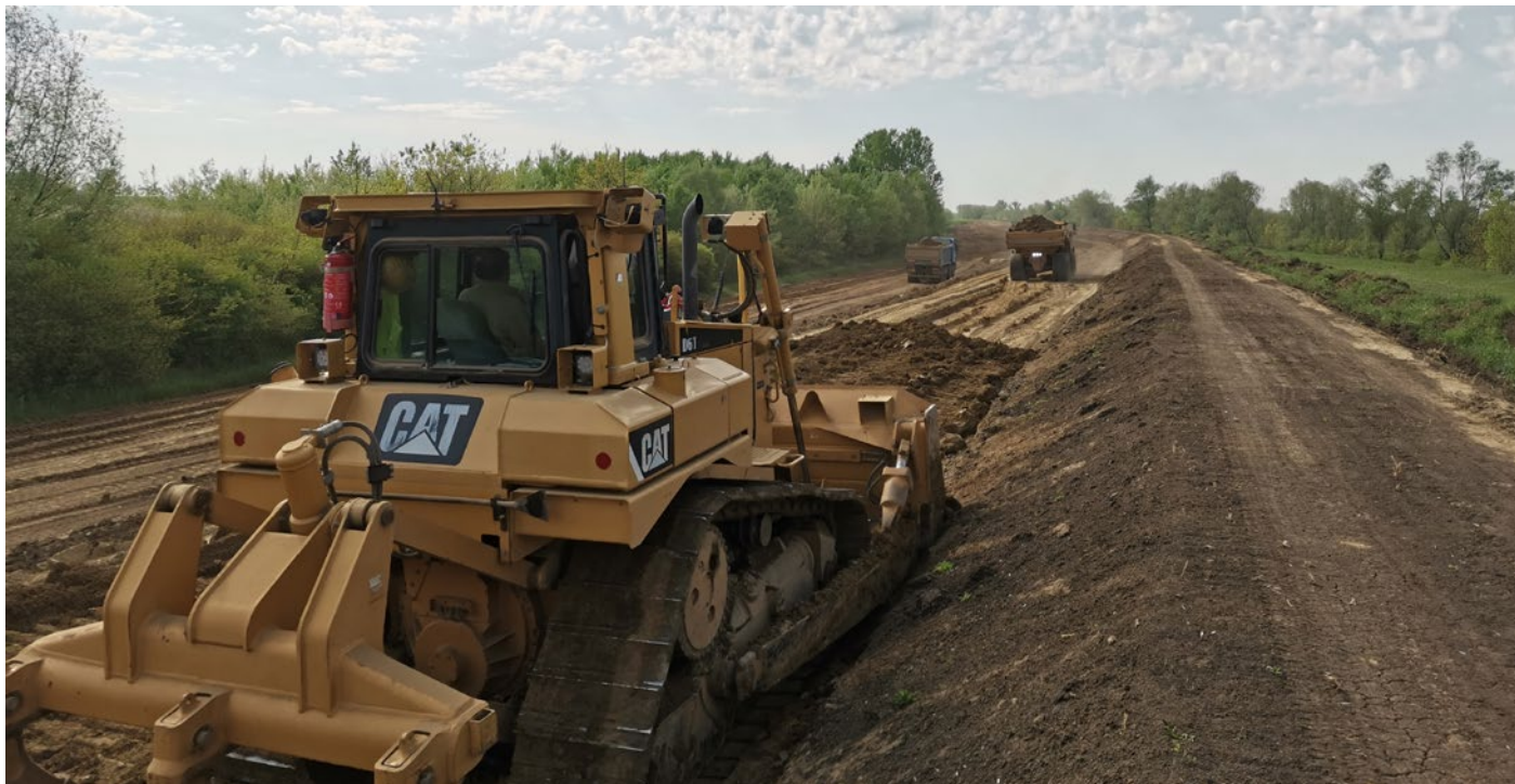
Töltésépítés Ópályi térségében
