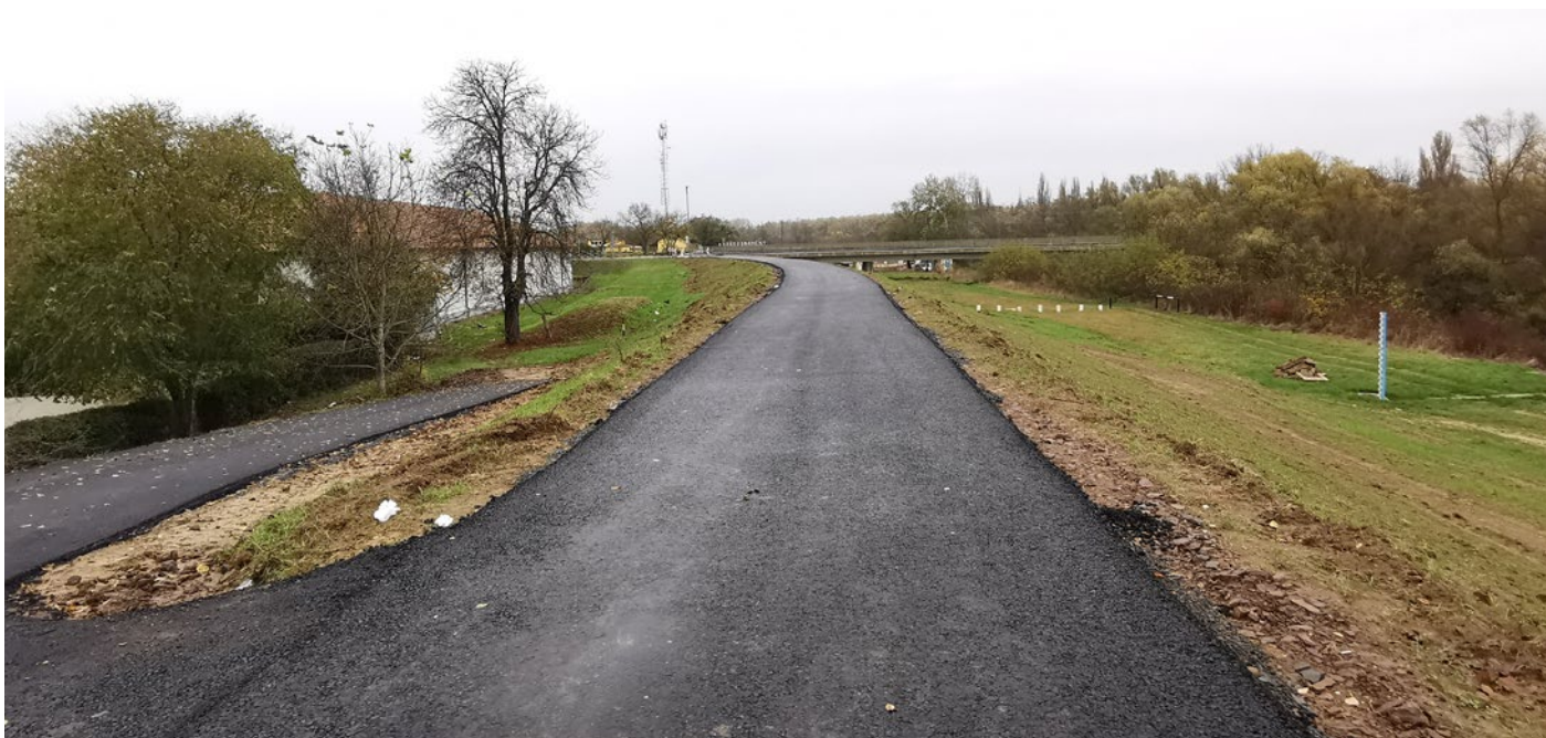
Elkészült a burkolt töltéskorona Vásárosnaménynál
