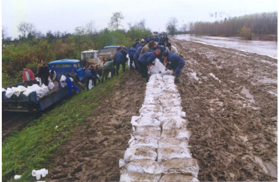
Nyúlgát építés Milota térségében
