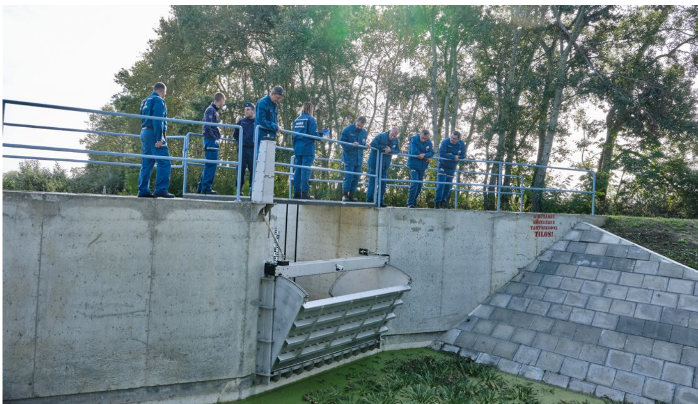
Védműfelülvizsgálati szemlén a bizottság a penyigei tározónál duzzasztó műtárgyánál
