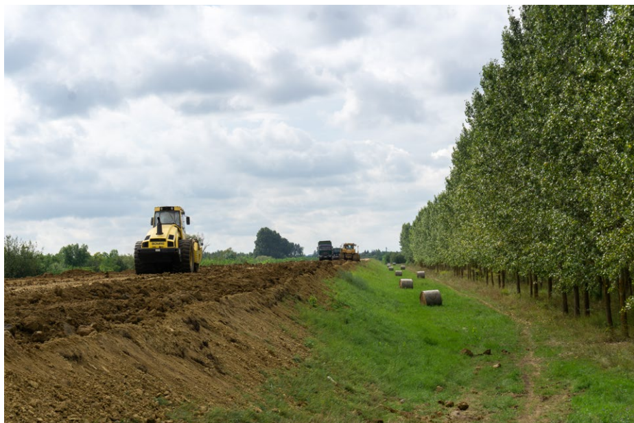
Töltésépítési munkálatok Ópályi térségében
