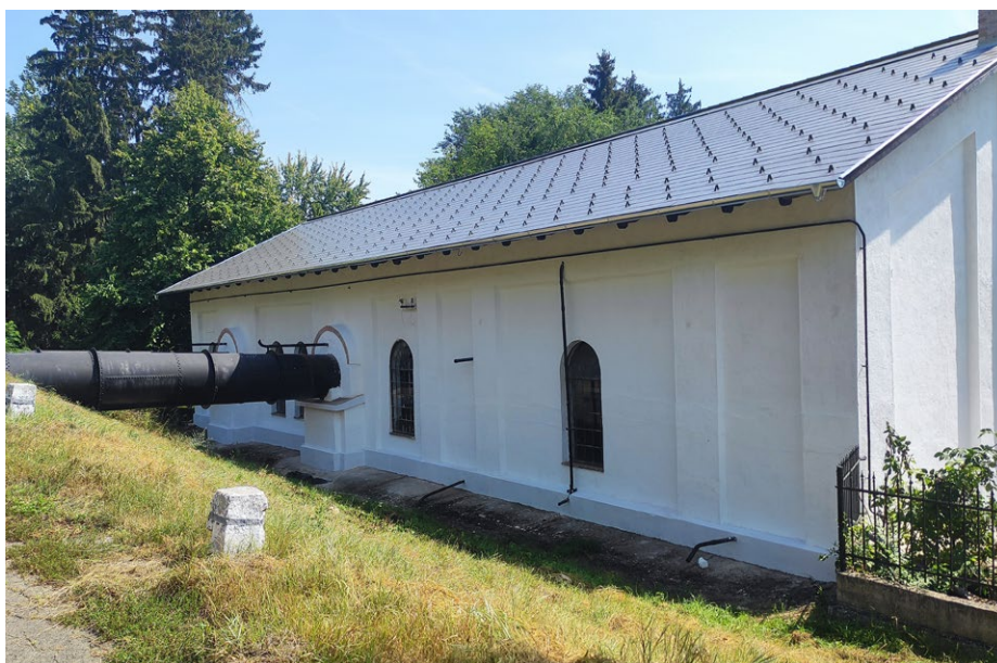
2.kép: a szivattyúgépház a felújítás utolsó szakaszában
