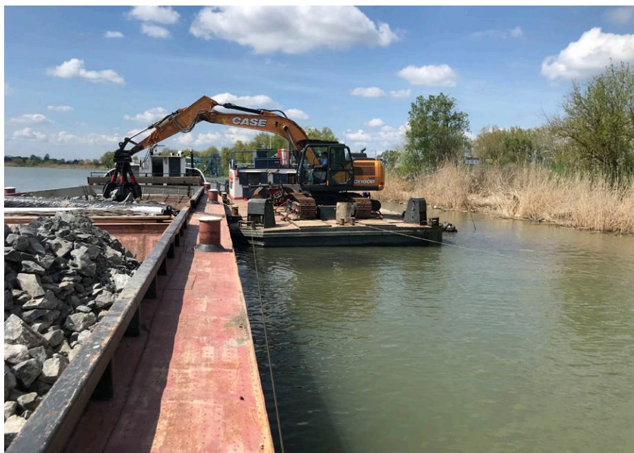
Vízárról történő partvédőmű építés
