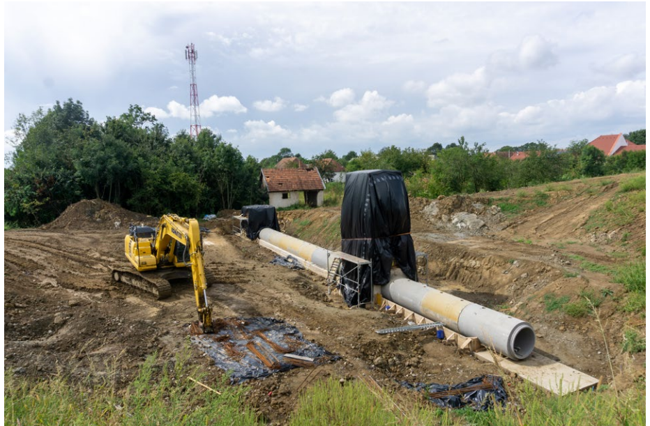
Magosligeti zsilip átépítése folyamatban
