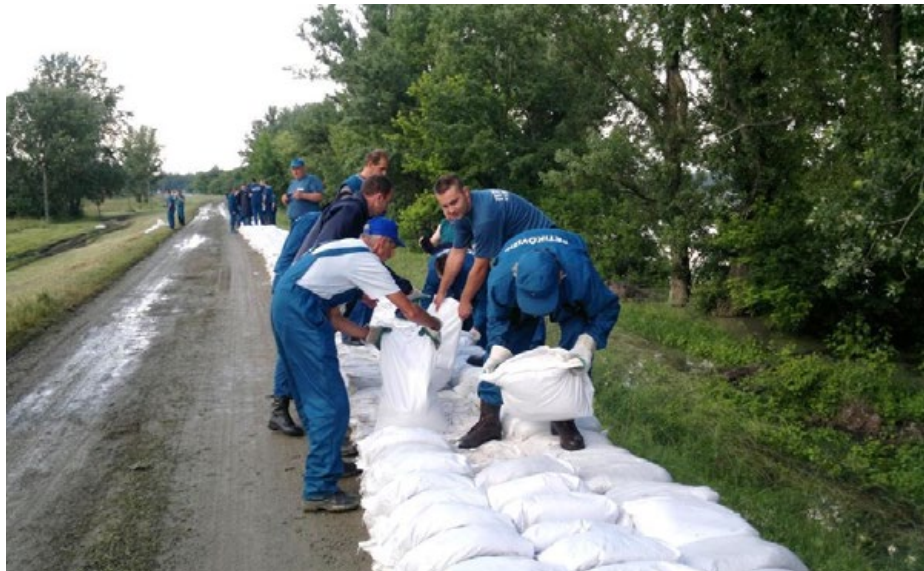
Védekezés magassághiány ellen a 02.07. sz. árvízvédelmi szakaszon
