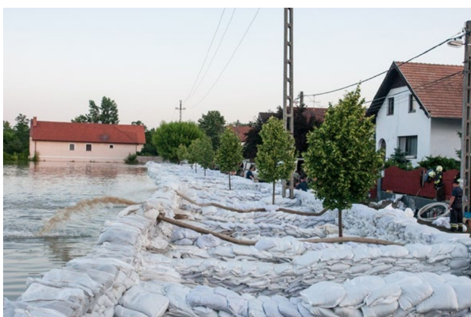
Kiépített ideiglenes védműrendszer Leányfaluban, a Kemping utcában
