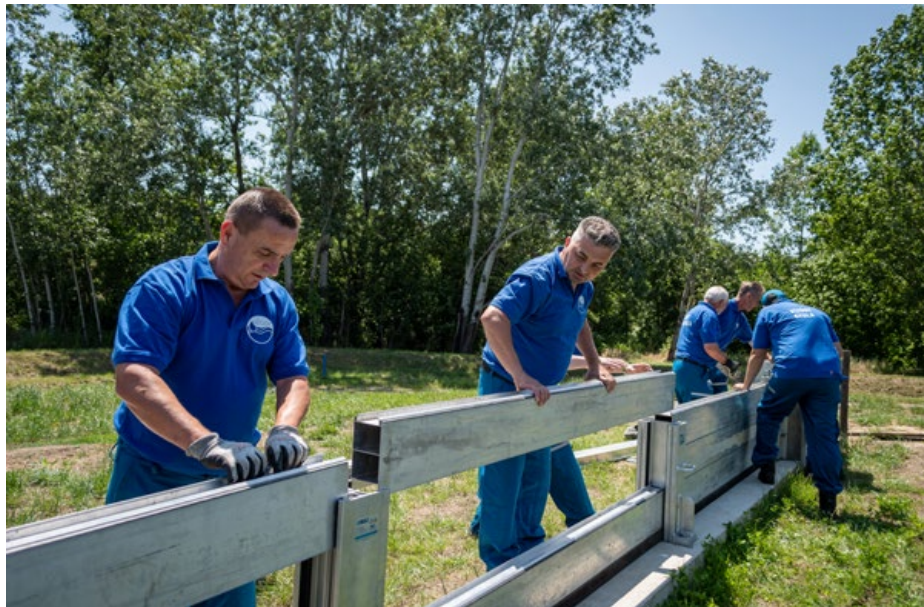
Mobilgát összeszerelését végzik a kollégák
