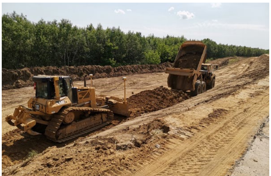
Töltésmagasítás a Kraszna mentén
