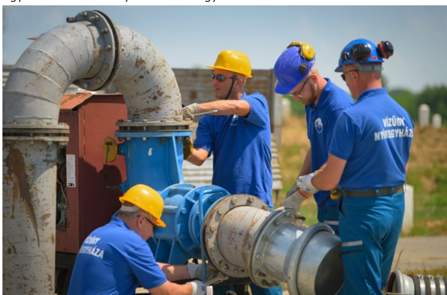
Mobilszivattyú összeszerelését végzi az MBSZ., Fotó: Romet Róbert
