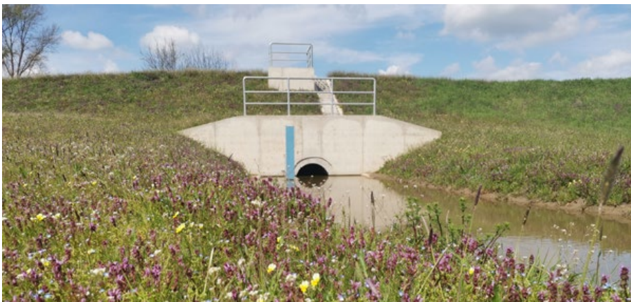
Új osztózsilip épült a Palád patakon
