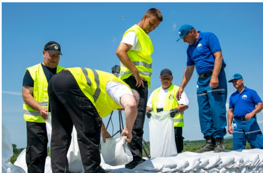
Nyúlgát építése homokzsákokból
