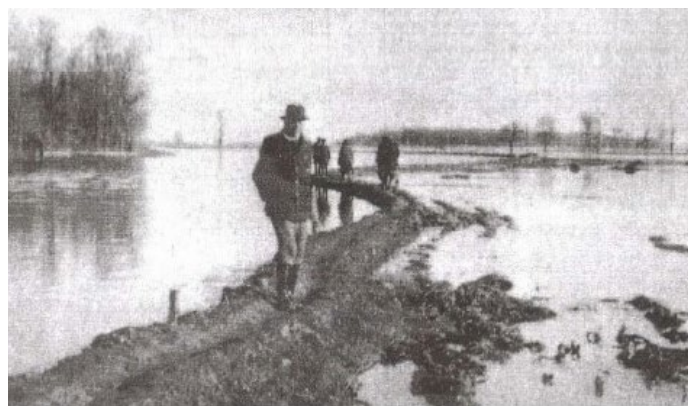
5. kép. A Szipa—Csaronda összekötő csatorna nyúlgátolt töltése (1948. január)
