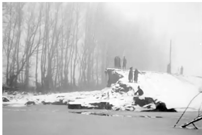
2. kép. A tivadari gátszakadás töltéscsonkjá 1948. január 1-én. (Filmhíradó on-line 1948)
