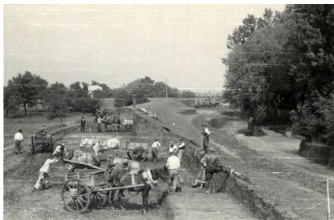
15. kép. Az 1947 szilveszteri gátszakadás után töltéskorrekcióval épülő új töltés-szakasz építése fogatos munkával (1) (1948) (Fotó: Konrád Rudolf)
