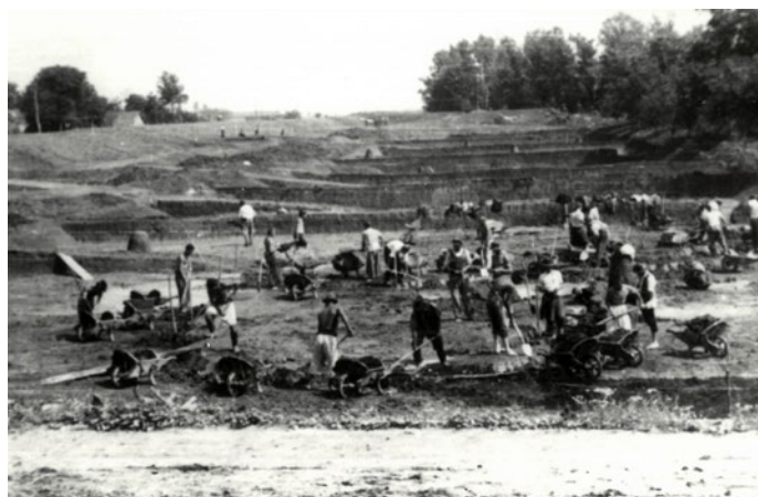
14. kép. A tivadari gátszakadás helyreállításán dolgozó kubikosok (1948) (Fotó: Konrád Rudolf)
