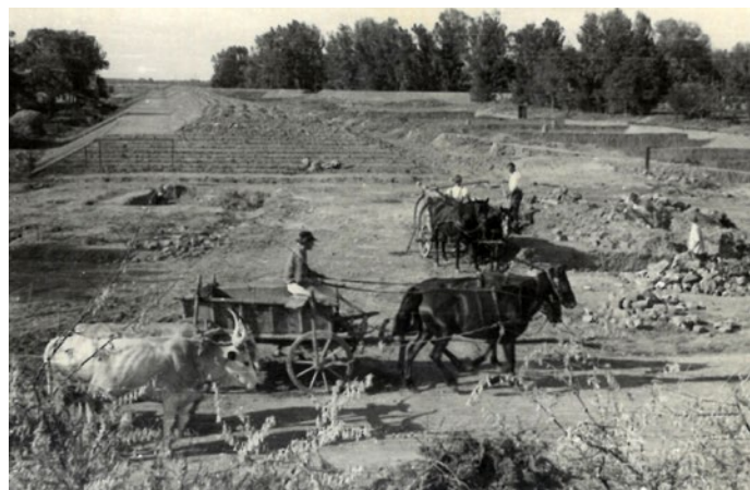
17. kép. Az 1947 szilveszteri gátszakadás után töltéskorrekcióval épülő új töltés-szakasz építése fogatos munkával (3)
