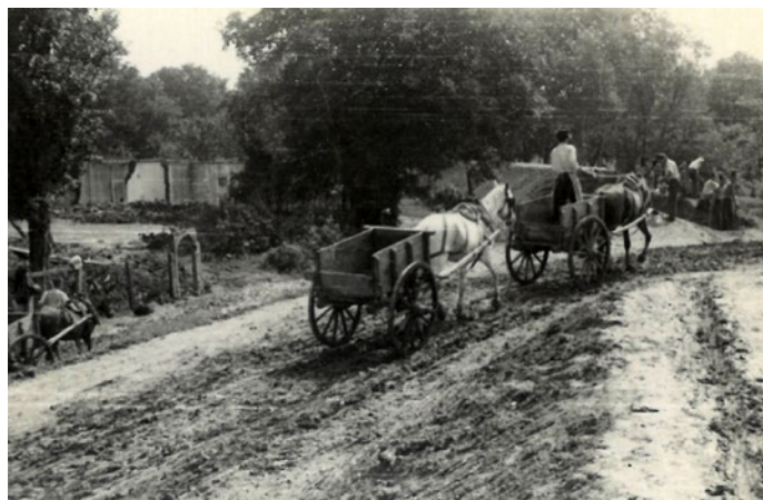
16. kép. Az 1947 szilveszteri gátszakadás után töltéskorrekcióval épülő új töltés-szakasz építése fogatos munkával (2)
