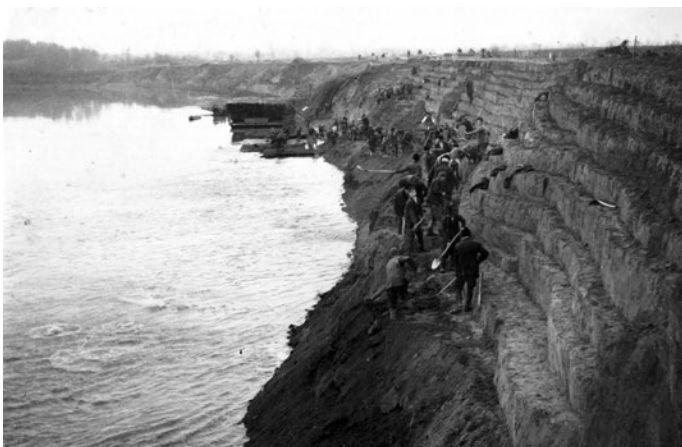
18. kép. A mezőladányi partbiztosítás építésének földmunkája (1948)
