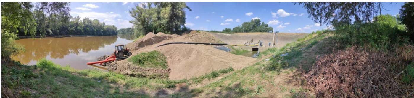
Szamossályi tározó mobil szivattyús vízpótlása a Szamos folyóból
