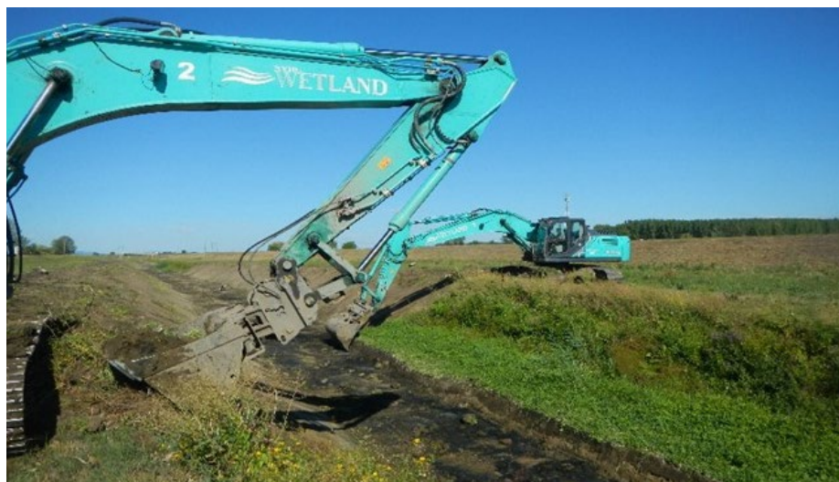
Lónyay-főcsatorna kotrása
