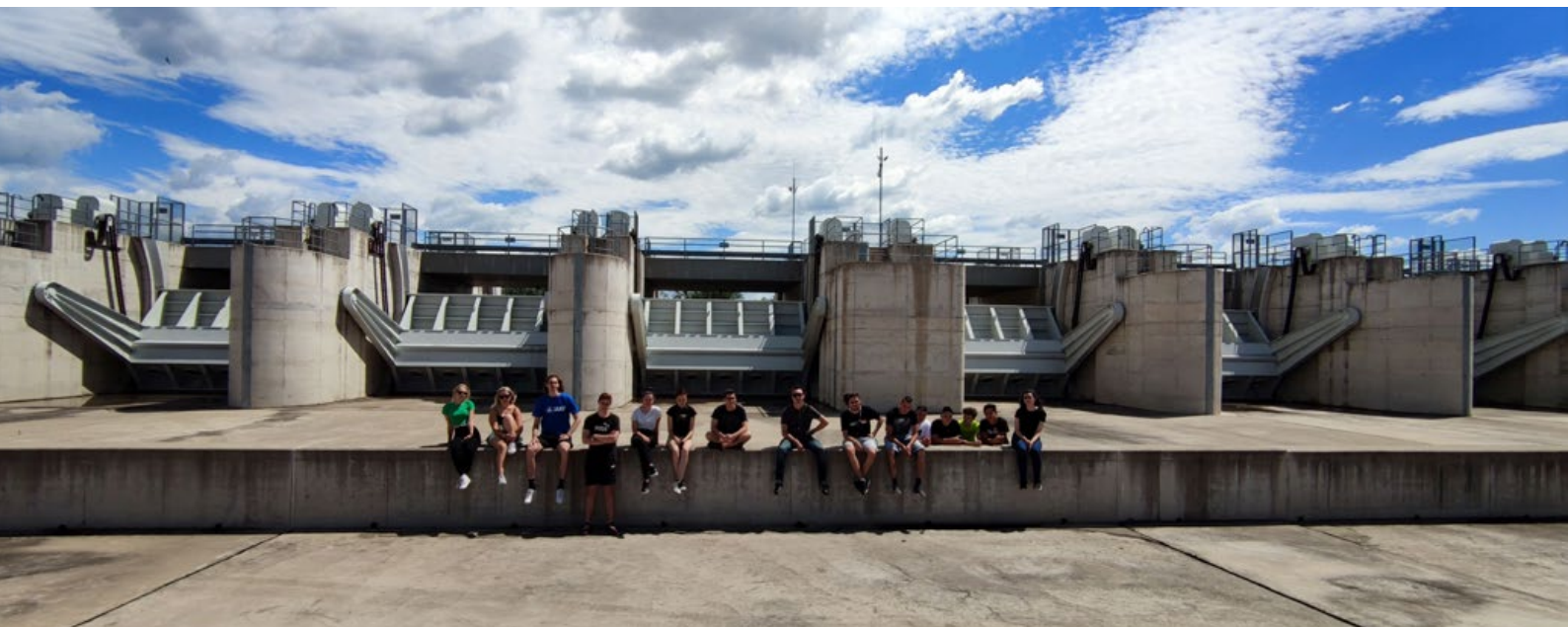
Tanulók a Szamos-Kraszna-közi árvízszint-csökkentő tározó beeresztő műtárgyánál
