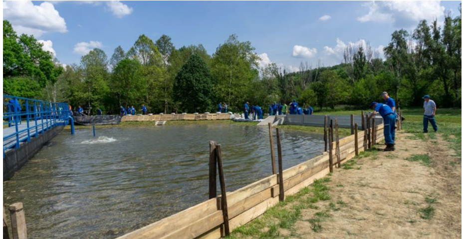
Töltésmagasítás pallófallal
