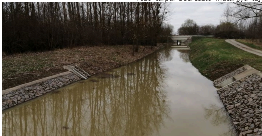
Makócsa-főcsatorna 2+850 km szelvényében lévő „Z5” jelű műtárgy a mentett oldalon
