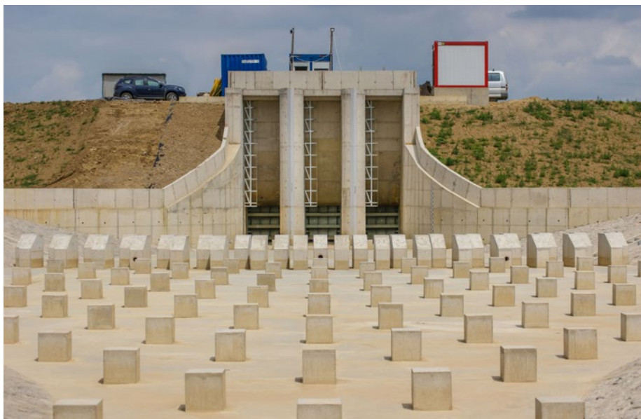
Vízleeresztő műtárgy a Túr felől
