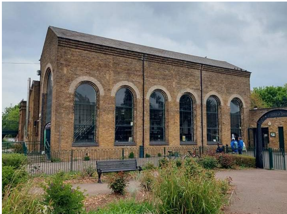
A szivattyútelep épülete kívülről nézve
