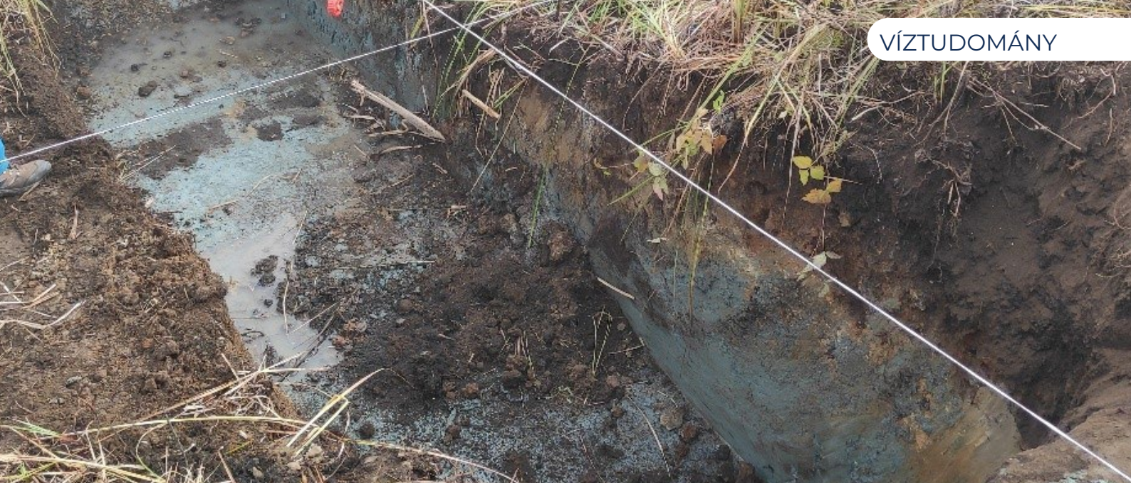
Munkagödör vízvisszatartó fenéklépcső helyén
