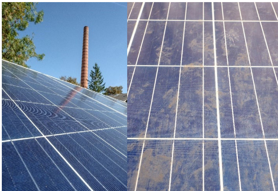
A Nagyecsed-i szivattyútelep napelempanelei – balra 2017. szeptember (új állapot), jobbra 2021. február (~3,5 év)
