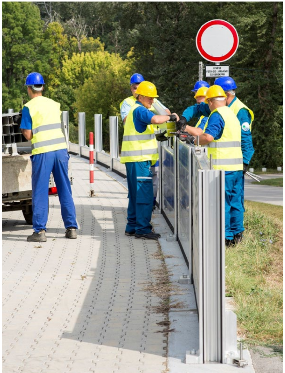
1. kép: Mobil árvízvédelmi fal elemeinek beépítése Tivadar településen
