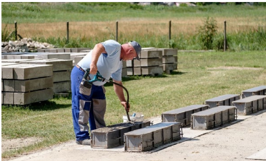
7. fénykép. Betonelemgyártás 2016-ban
