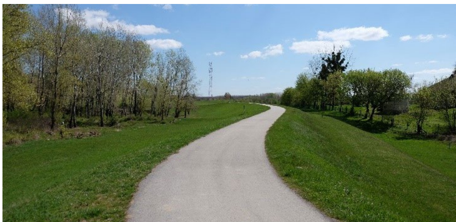
3. fénykép. Az elkészült aszfaltburkolat Dombrád térségében 2011-ben (az építés folyamata a főcímnél szereplő képen látható)
