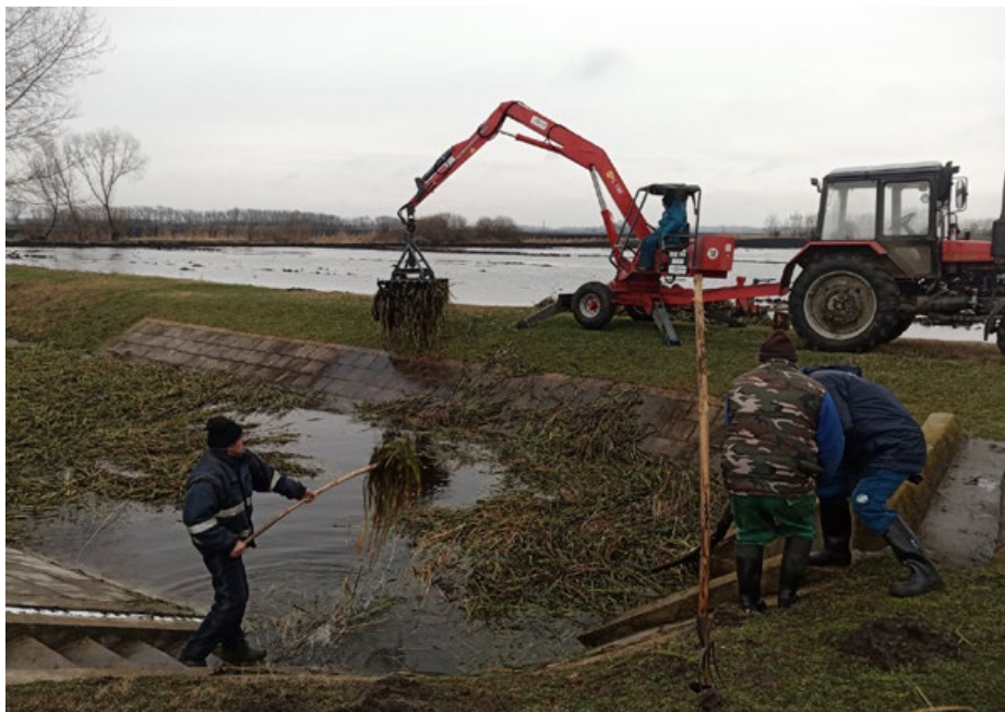
Nagyhalász-Pátrohai csatorna 12+100 km szelvénye
