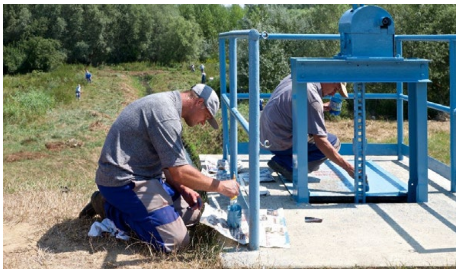
6. fénykép. Műtárgy fémszerkezetének korrózióvédelme 2015-ben
