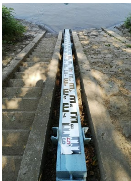
A dombrádi törzsállomás felújított vízmércéje
