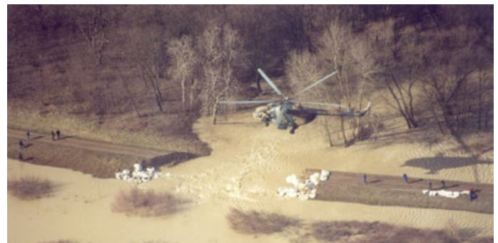
9. kép. Töltéscsonk bevédés a Túron helikopteres anyagszállítással
