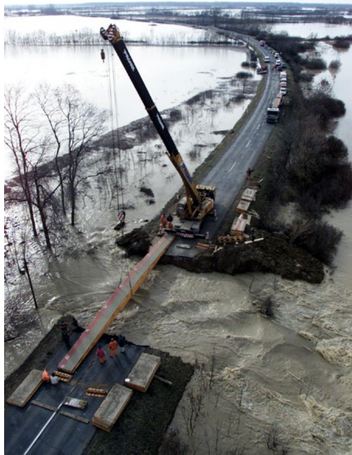
27. kép. Ideiglenes híd építése a 41. sz. főút átvágásának áthidalására
