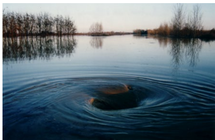
25. kép. Vízöntés a 41-es műút alatti áteresznél
