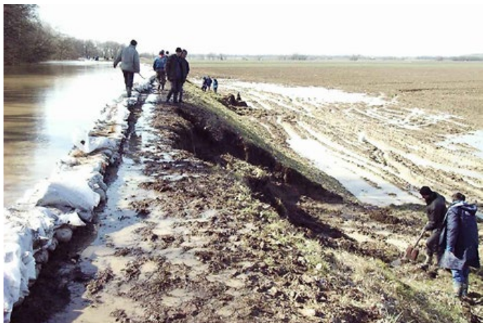
11. kép. A suvasadások sorozatban alakultak ki a Tisza jobb parti töltésén, a Beregben (2001. március 6.)
