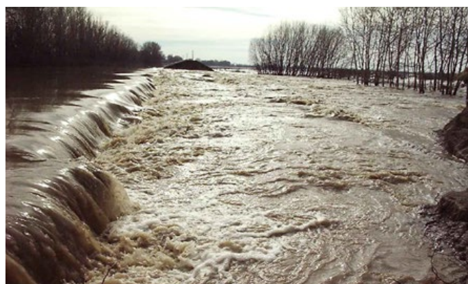
16. kép. Bukóélszerű töltésmaradvány a tiszai szakadásnál
