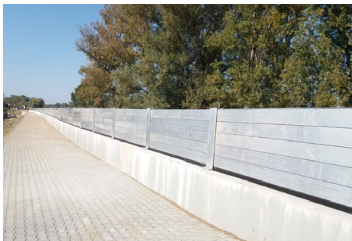
35. kép. Mobilfal a Tisza bal parti töltésén Kisarnál (2019)
