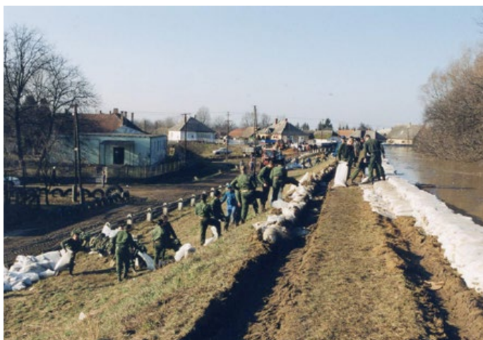
4. kép. Nyúlgát építése Kisarban a tetőzés előtt
