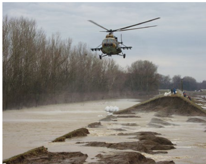
18. kép. Konténerzsákok szállítása helikopterrel a tarpai felső szakadáshoz (2001. március 9.) (Fotó: Vincze Zoltán)
