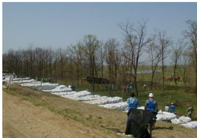
2. kép. Töltésrészsú bordás megtámasztása a Felső-Tiszán (2001. március 6.)
