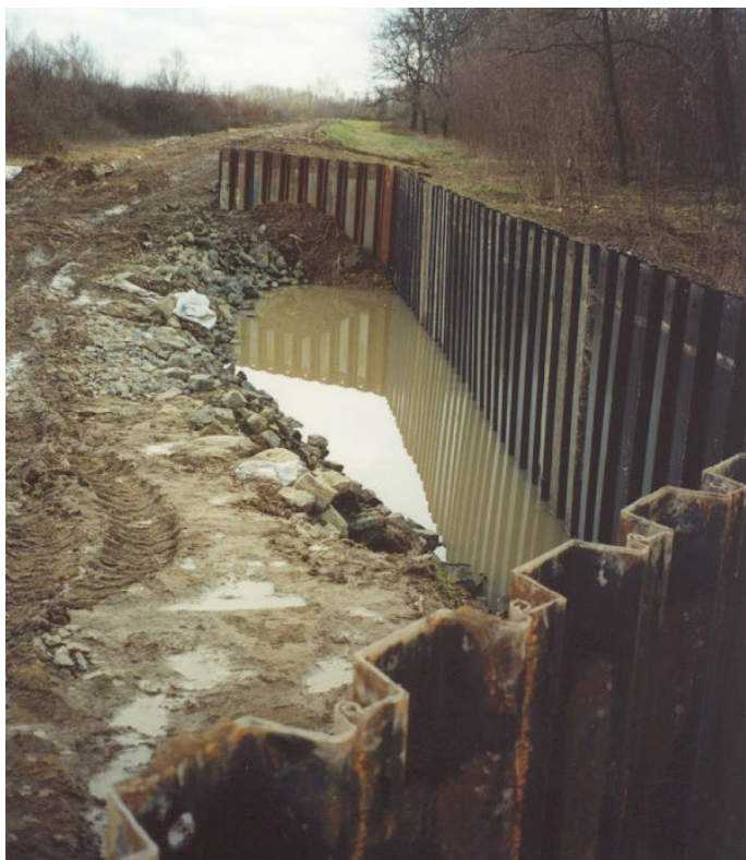
17. kép. Ideiglenes elzárás a Túron szádlemezekkel
