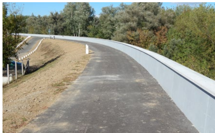
33. kép. Parapetfal a Tisza bal parti töltésén Tiszabecsnél (2019)
