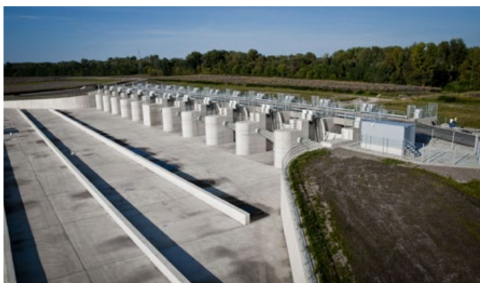
36. kép. A Szamos-Krasznaközi árvíz tározó feltöltő műtárgya Tunyogmatolcsnál (2014)
