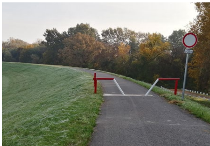
32. kép. A Tisza jobb parti töltése Tivadar-Tarpa között (2020)
