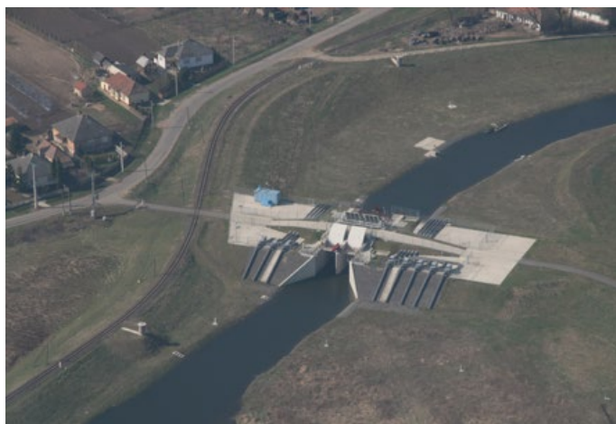
38. kép. Lónyay-főcsatorna árvízkapu (2007)
