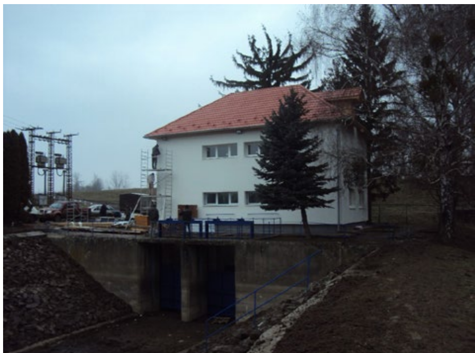
Megújult az olcsvai szivattyútelep
