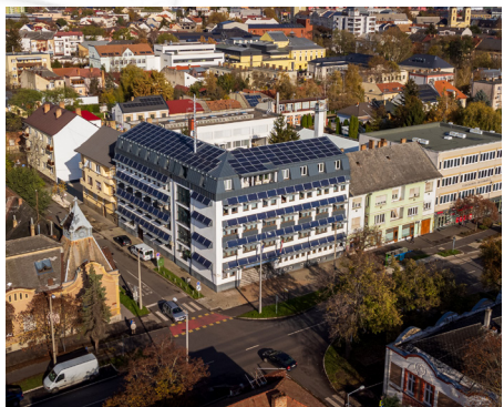
A Felső-Tisza-vidéki Vízügyi Igazgatóság központi épülete (2026)
