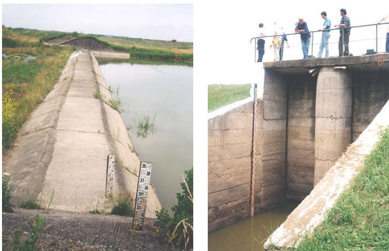
1-5. ábra A Nagymajtényi vésztározó feltöltésére szolgáló bukó (a) és vízleeresztő zsilip (b)
